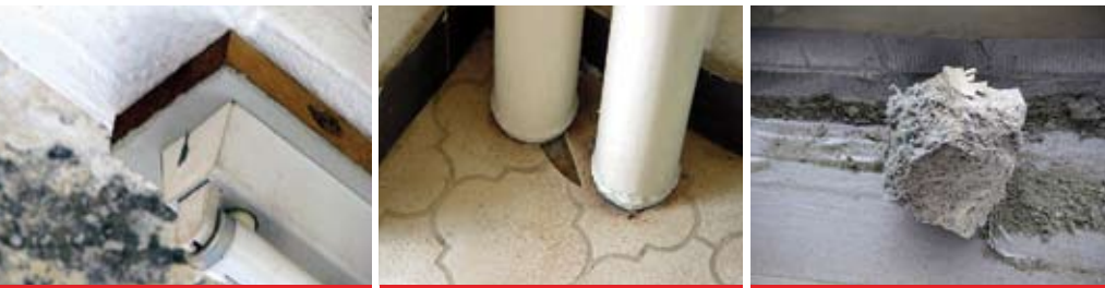
Asbesthaltige Leichtbauplatte
